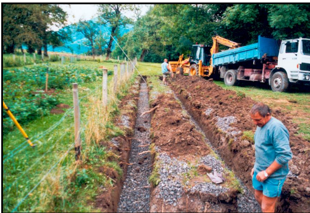
Tranchées d'épandage en cours de réalisation
