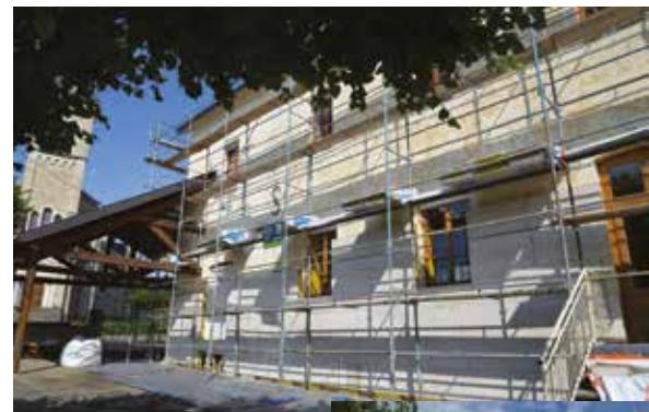
La Commune a lancé des travaux de rénovation énergétique sur l'école. Cela a débuté par le doublage des murs par l'extérieur et par l'isolation du sol du rez-de-chaussée par la cave. L'installation de nouveaux volets roulants fonctionnant à l'énergie solaire a signé la fin du chantier début octobre. Cette rénovation a été financée à 80 % par des subventions, 40 % ont été portés par l'Etat, 40 % par la région.
