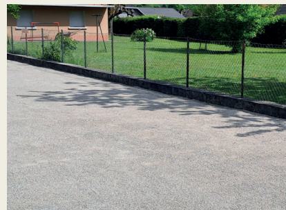
Terrains APRÈS remise en état
