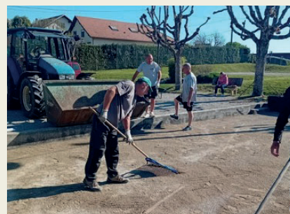
Terrains en travaux
